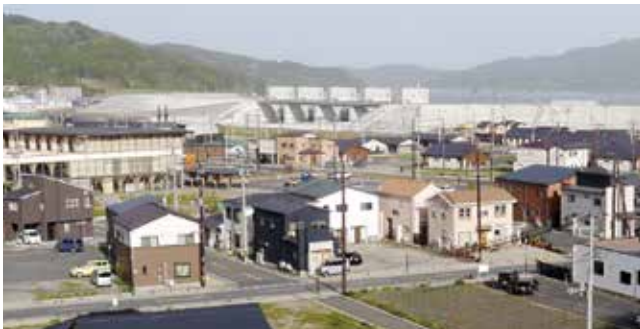
整備された防潮堤と水門（大槌町）
