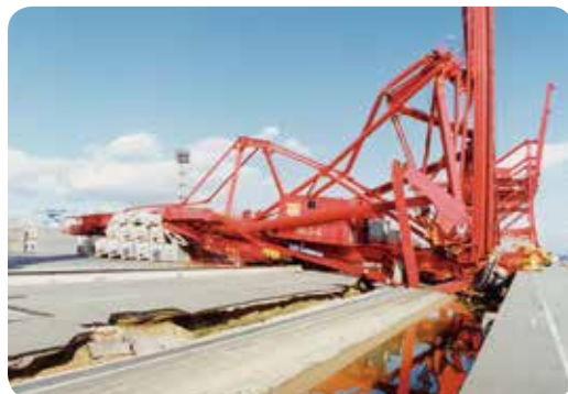
倒壊した神戸港のガントリークレーン (写真：神戸市)
