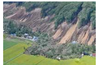
北海道厚真町の土砂崩れの様子
