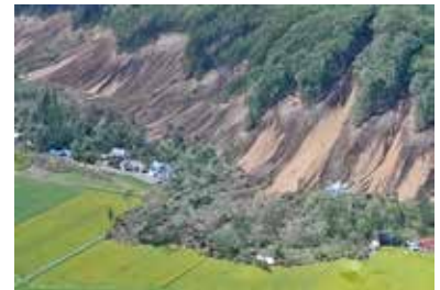
北海道厚真町の土砂崩れの様子
