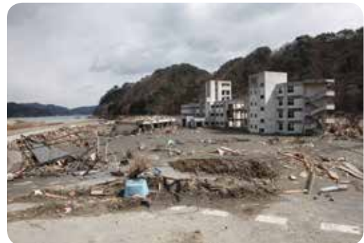
津波の被害を受けた釜石東中学校（写真：いわて震災津波アーカイブ / 提供者：釜石市、平成 23 年 3 月 23 日撮影）
