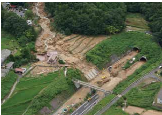
山陽自動車道（志和トンネル付近）
