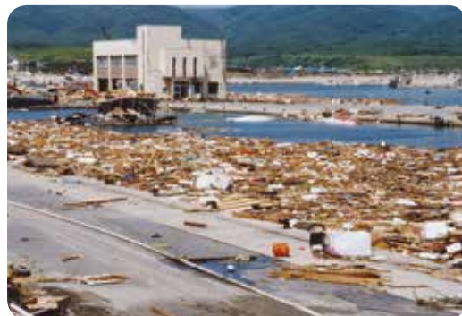
津波の被害を受けた奥尻町（写真提供：奥尻町）
