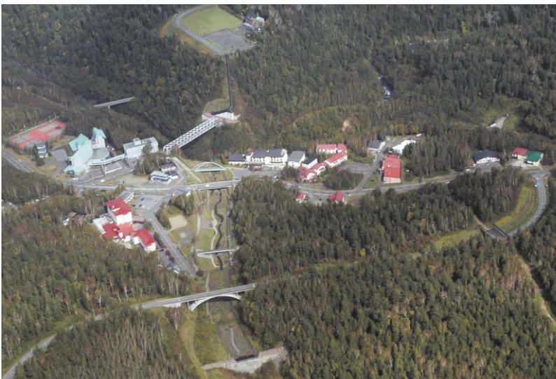
■白金温泉地区に建設された砂防施設、緊急避難路と防災情報センター
