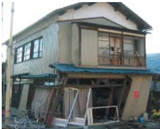
写真2 地震動による建物傾斜
