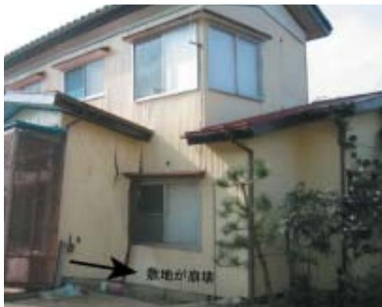
写真1 地盤崩壊による住宅の被害
