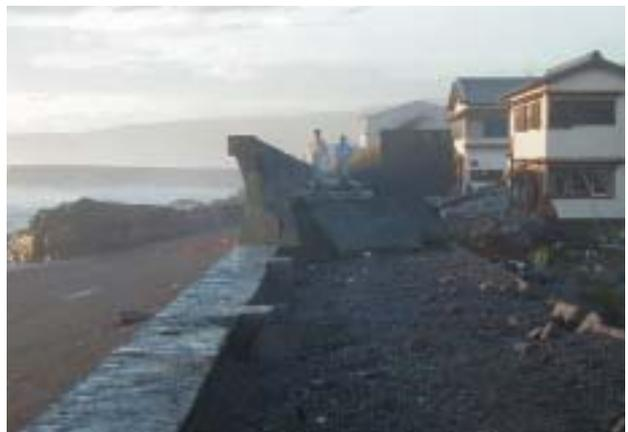
台風第23号の高波により倒壊した防波堤（高知県室戸市）
