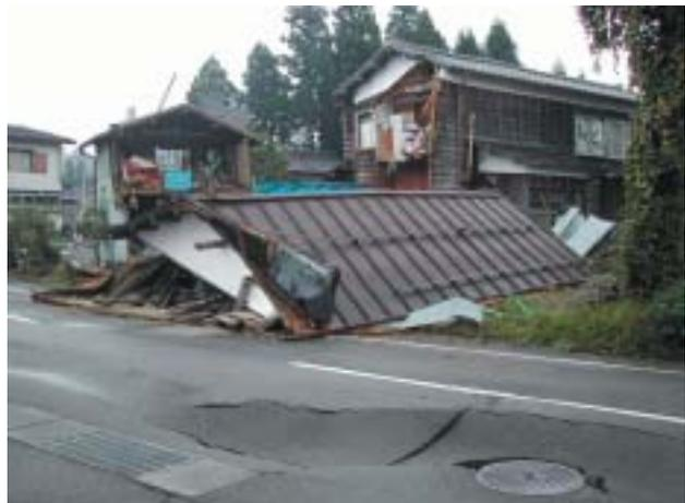
震度7を記録した川口町の被害(住宅の全半壊・道路陥没)
