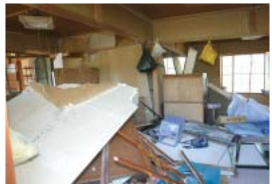
内部が激しく壊れた住宅（浦河町字東栄）
