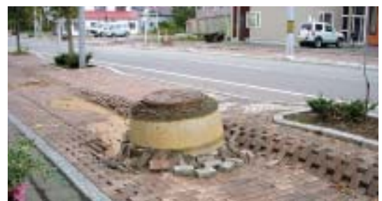
液状化により浮き上がったマンホール
