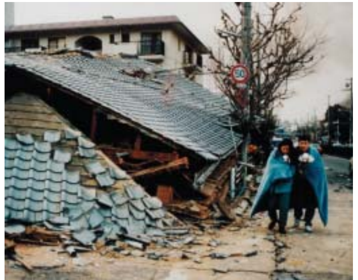
阪神・淡路大震災で倒壊した家屋
