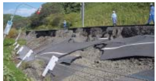
崩壊した道路（道道912号大津長節線）
