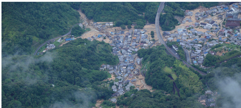
図 2 土砂災害の状況（広島県安芸郡坂町小屋浦付近）
