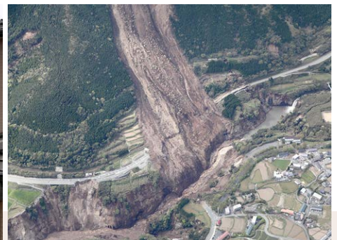
地震による大規模な土砂崩れで 阿蘇大橋が崩落、死者も発生
