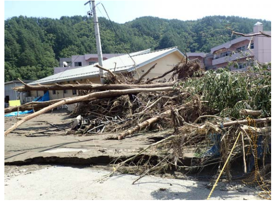
岩手県岩泉町のグループホーム被害状況
