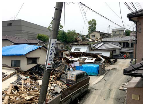
多数の家屋が倒壊（熊本県益城町）
