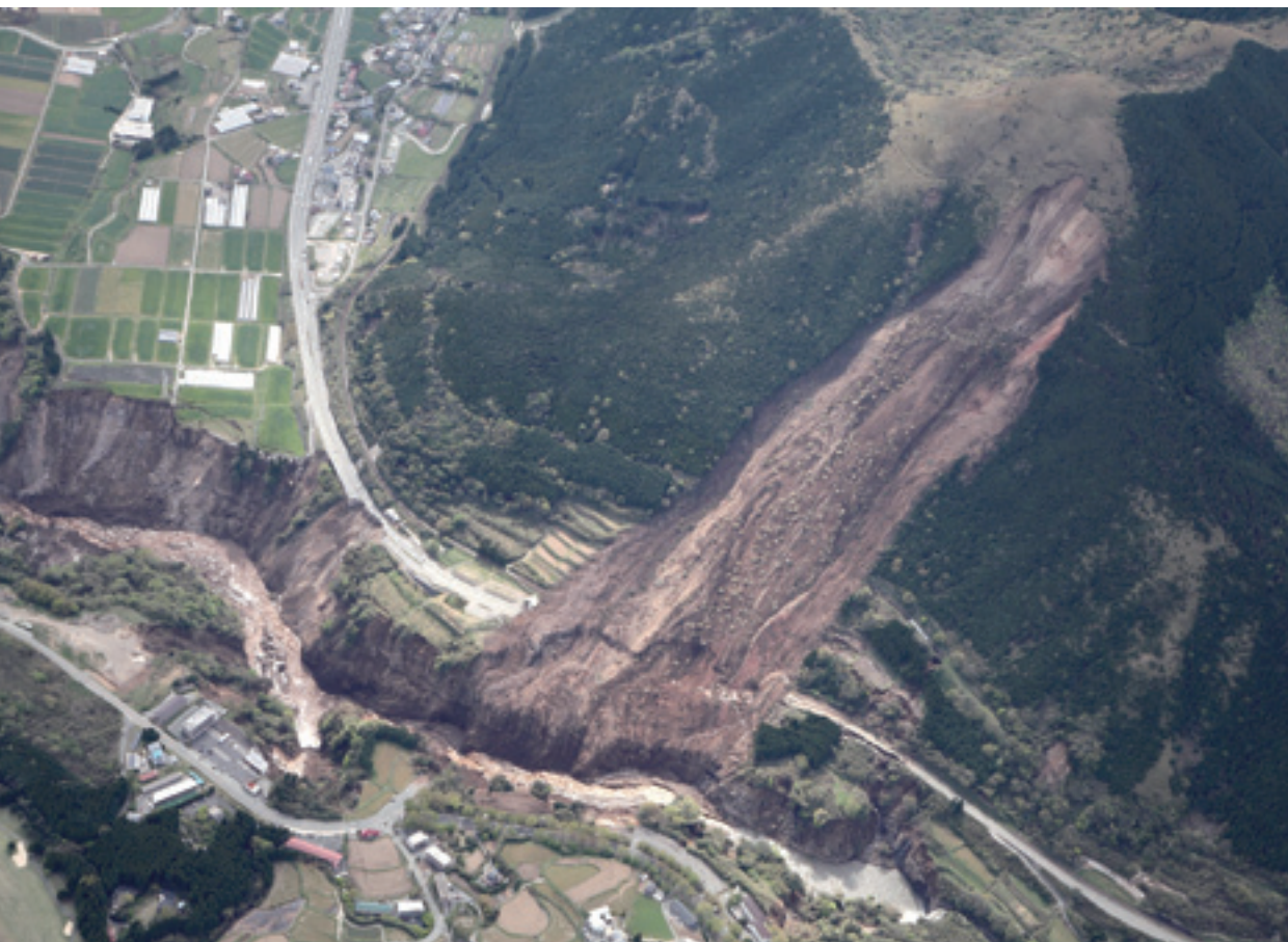
地震による大規模な土砂崩れで阿蘇大橋が崩落し、死者も発生しました。
