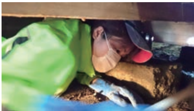
2015年9月の関東・東北豪雨により被災した家で、床下の土砂の除去を行う防災ガールのメンバー
