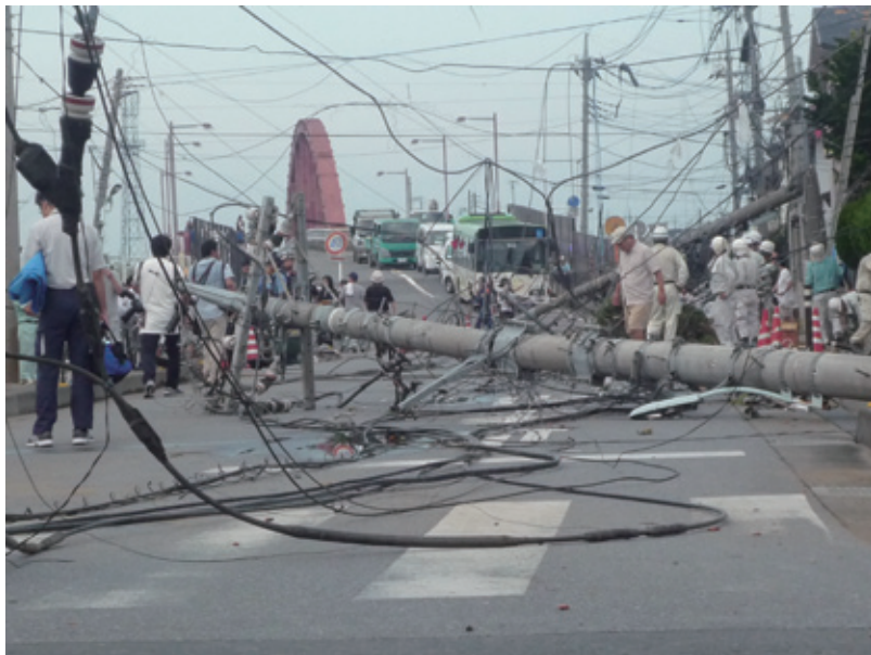
平成25年9月2日に発生した竜巻による埼玉県越谷市の被害の様子
