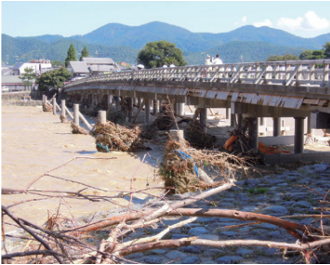
被災後の渡月橋（京都市右京区嵐山）
