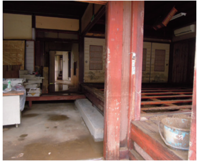
住宅街の被害（京都府福知山市）
