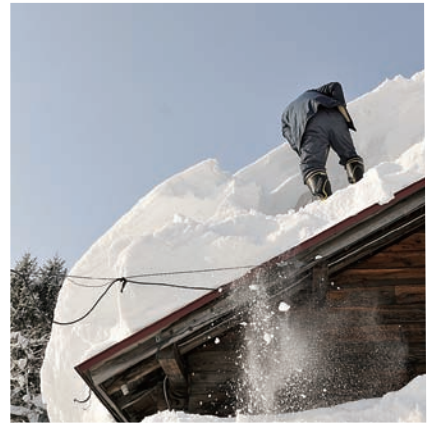
屋根の雪下ろし
