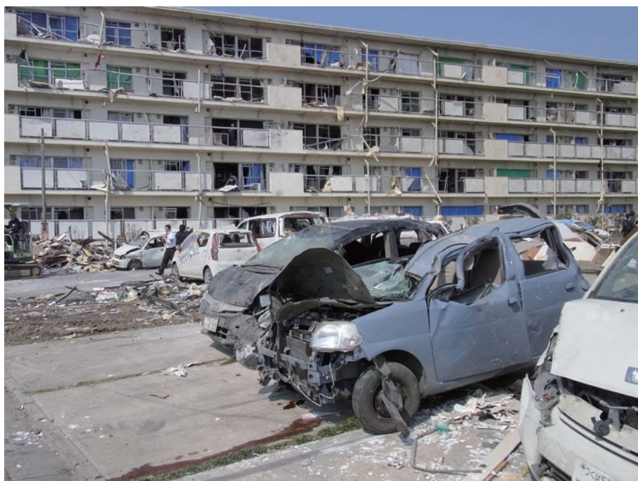
竜巻による被災現場（茨城県つくば市北条地区）
