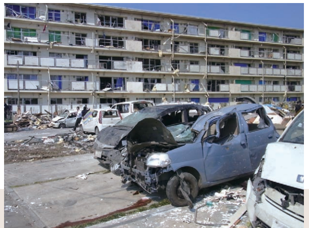
茨城県つくば市北条地区の被災状況（5月7日）
