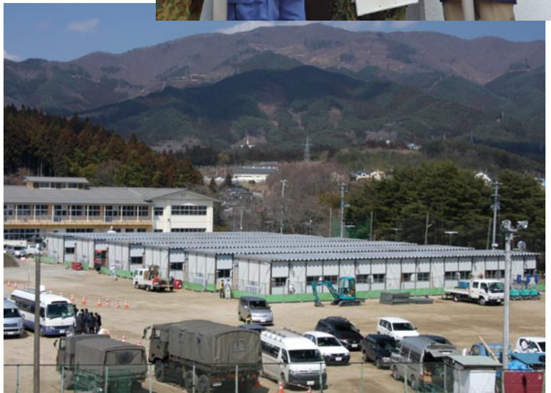
建設が急ピッチで進められている仮設住宅（社団法人プレハブ建築 提供）
