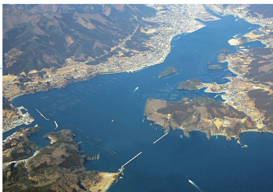
大船渡湾湾口に作られた世界最初の津波防波堤 (国土交通省釜石港湾事務所のホームページより)
