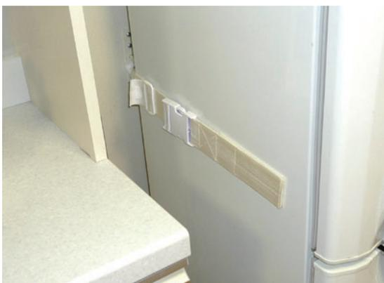
冷蔵庫をベルトストラップで固定する際は、壁にしっかりビス止めし、粘着面をきれいにするのがポイント
