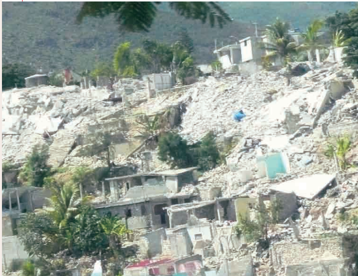
ポルトープランス郊外にある傾斜地の倒壊した住居群
