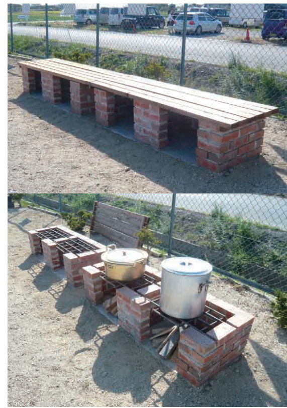
彦根市金剛寺町グラウンドに設置された「防災かまどベンチ」 通常は「ベンチ」として、災害時には「かまど」として使用できる (写真提供 彦根工業高等学校)
