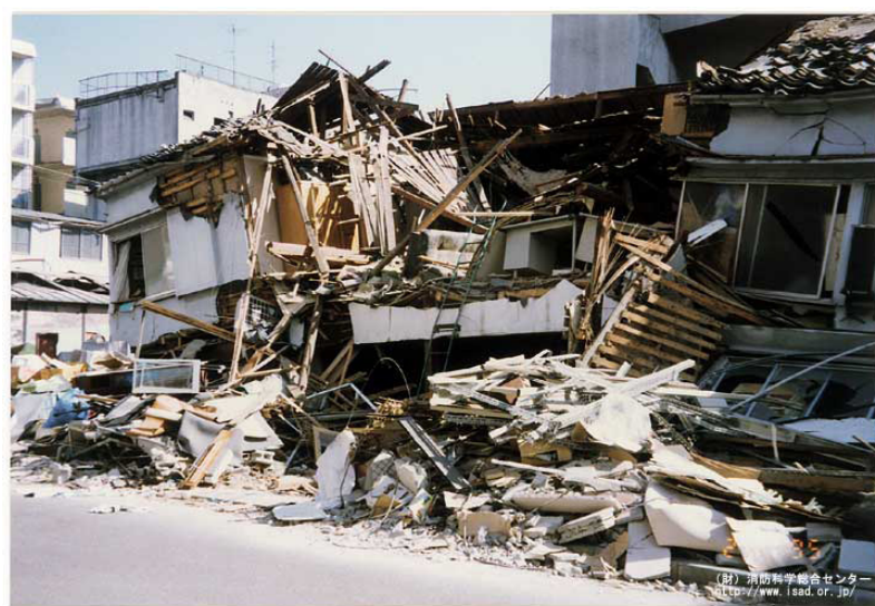
阪神・淡路大震災で全壊した住宅（神戸市）（財団法人消防科学総合センター提供）
