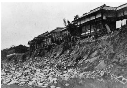
洪水後の新川左岸の侵食状況 渡良瀬川からの洪水流の流れ込みによって 小規模な河川の川幅は著しく広がった (カスリーン災害記録集I、洪水写真集、 建設省渡良瀬川工事事務所、1998)
