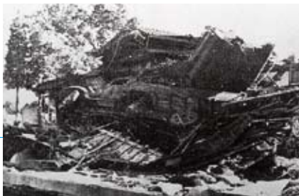
氾濫流により家屋に衝突するトラック 洪水流が運ぶ流下物が被害を拡大する (カスリーン災害記録集I、洪水写真集、 建設省渡良瀬川工事事務所、1998)
