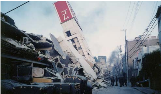
ケミカルシューズ関連のゴム会社のビル倒壊 (写真提供：メック・ラボ、撮影：矢内秀和)
