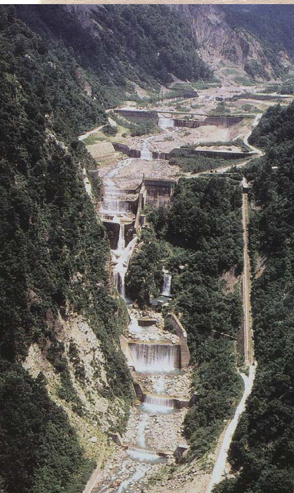
白岩砂防堰堤
