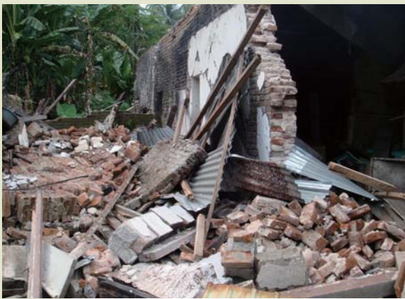
レンガ造の被災家屋。鉄筋の柱がないか、きわめて細い (パリアマン市内、10月6日)
