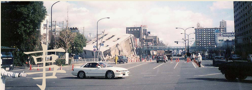
阪神・淡路大震災で倒壊したビルと街路（写真提供：メック・ラボ、撮影：矢内秀和）
