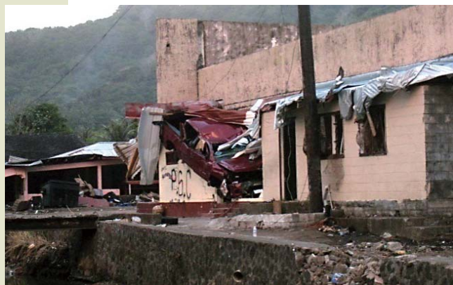
大破した自動車が建物に突き刺さったバゴバゴ公園の被害
