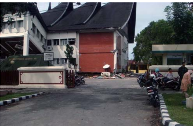
1階部分が潰れた公的施設。大きな屋根構造が特徴的(パダン市内、10月5日)
