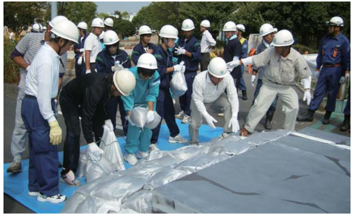
液状化対応訓練（道路の応急復旧）
