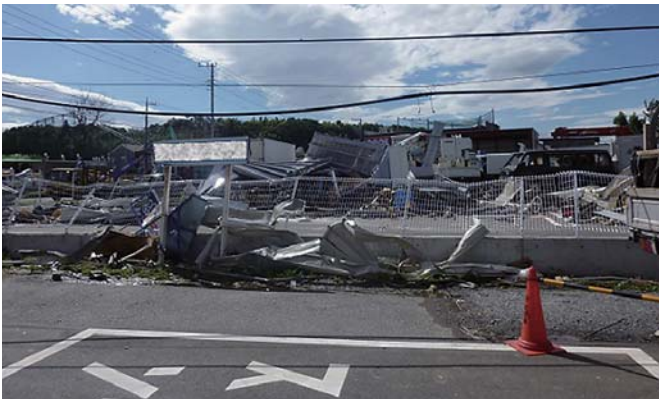
茨城県土浦市で発生した突風による木造店舗倒壊とフェンスの倒れ (資料提供：気象庁)
