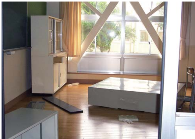
事例2：耐震補強をしていたため建物には被害がありませんが、部屋の中はごらんの通り
