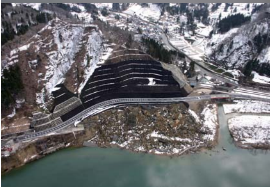
被災現場の復旧状況（長岡市妙見町）（写真提供：新潟県）
