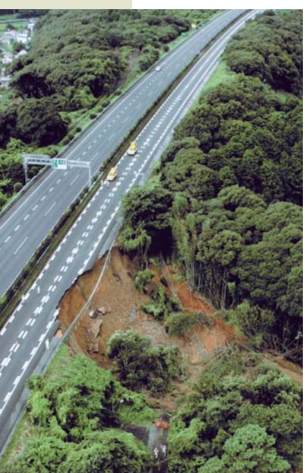
静岡県牧之原市で一部崩落した東名高速道路(写真提供:中日新聞)
