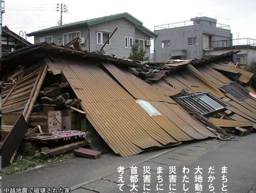
中越地震で破壊された家 (写真提供: (株)アイジーコンサルティング)
