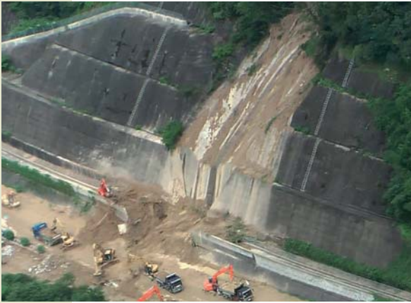
福岡県大野城市では高速道路が被災し、2人が亡くなった
