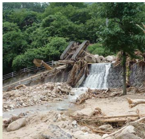
防府市下右田では国道262号線付近で土砂崩れが発生。4人が亡くなり、道路は全面通行止めになった
