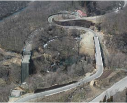
一関市祭時大橋の落橋現場と仮橋の開通
