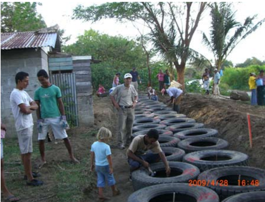
コスタリカでの古タイヤ堤防試験施工の様子（写真提供：JICA）
