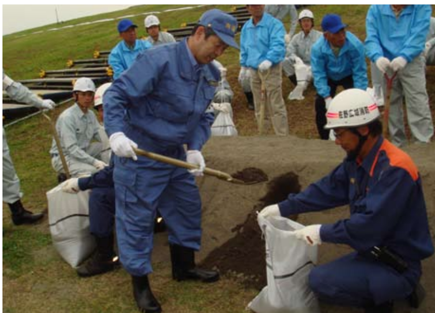
土のうづくり
