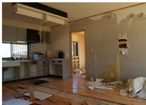
写真2 浸水した壁内部の部材取り外しに伴う他の部材の取り外し
