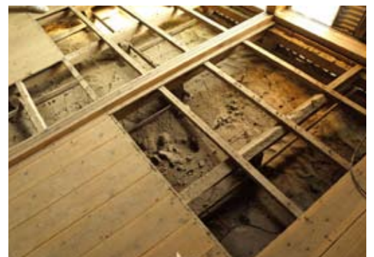
写真1 床下への汚泥堆積と汚泥除去のための床板の取り外し
