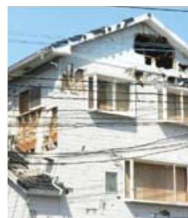
写真4 風害に伴う飛来物による損傷(写真提供:延岡市)
