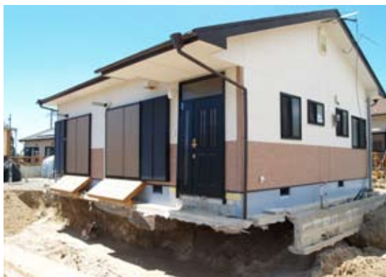
写真3 基礎の直下の地盤の流出
