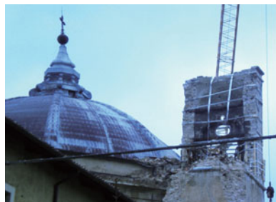
教会の塔が崩れ落ちた状況
