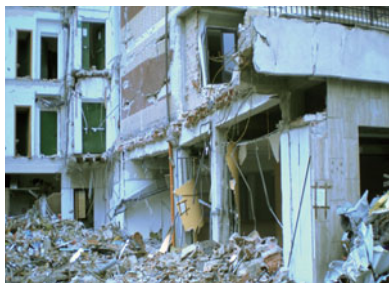
倒壊した学生寮
