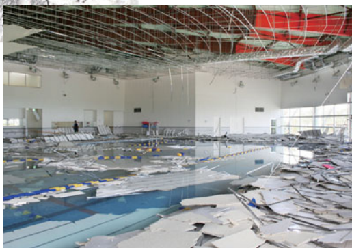
平成 17 年 8 月 16 日に発生した宮城県沖を震源とする地震。写真は、天井のパネルが落下したプール（写真提供：時事）
