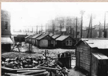
幹線街路予定地に建てられた臨時収容家屋（出典：復興事業局（昭和6年）「帝都復興事業誌土地区画整理篇」挿絵「移転工事中臨時居住せしめたる移動バラックの一群（其の一）」）
