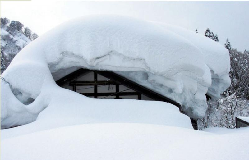
3m を超える積雪に耐える家屋。中越地震後でも十分な強度をもっていましたが、その後完全に倒壊した（平成 17 年 2 月 3 日新潟県山古志竹沢）
