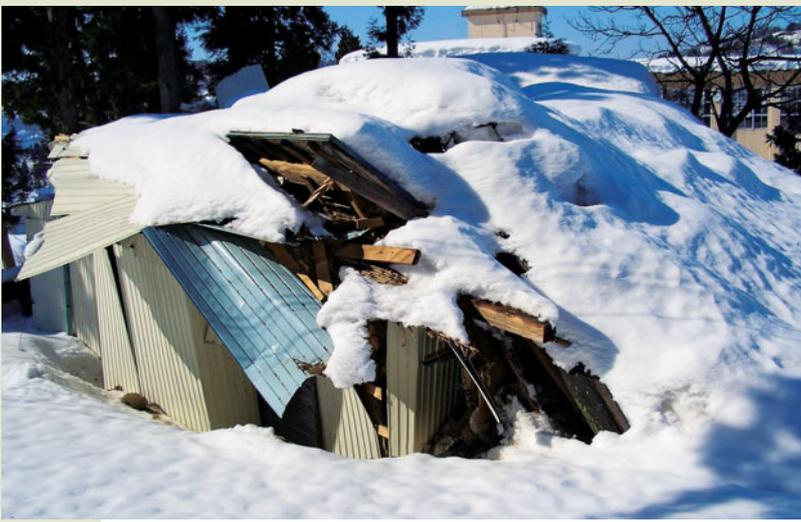
中越地震後の冬、損壊を受けた状態で雪下ろしができなかったため、雪の重みで押しつぶされた家（平成 17 年 1 月 29 日 新潟県長岡市山古志竹沢）
