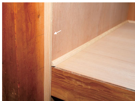
補強工事後の押入れ。←の内側に構造用合板がある
