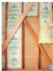
倉庫内の補強工事。筋かいが1本しかなかったため、新たに1本を追加（手前の新しい材木）
