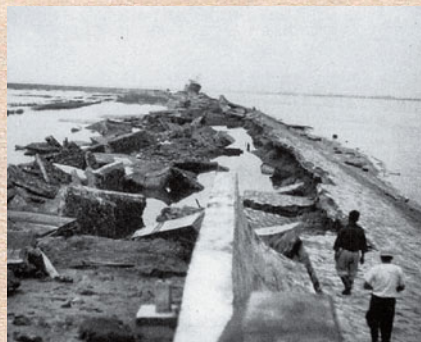
写真-1 半田武豊海岸堤防の被災（出典：中日新聞社『伊勢湾台風の全容』）
