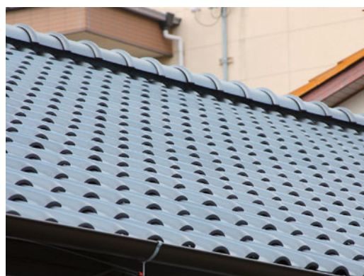
本瓦（土をのせない場合）より1㎡あたり約20kgも軽くなる軽量瓦
