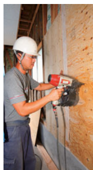
厚さ7.5mm以上の強度の強い板材、構造用合板を張っているところ
