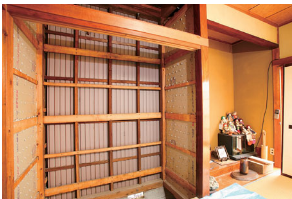
押入れは、内部をすべて外したのちに筋かいを入れ、構造用合板を張る。中央と左右の壁を同時に補強できる利点もある
