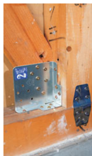
柱と土台や、柱、土台、筋かいを固定する接合金物
