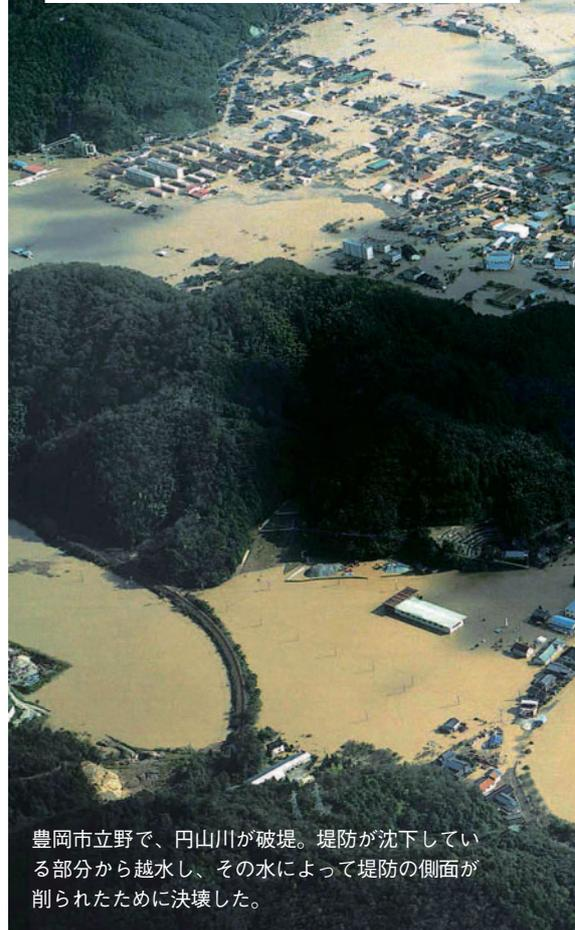
豊岡市立野で、円山川が破堤。堤防が沈下している部分から越水し、その水によって堤防の側面が削られたために決壊した。
