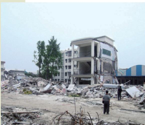
階段を残して倒壊した校舎（都江堰市聚源鎮）。
