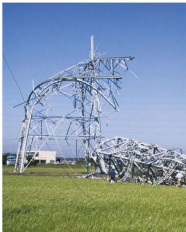
暴風によって倒壊した、茨城県潮来市の送電線の鉄塔。(写真提供：東京管区気象台)
