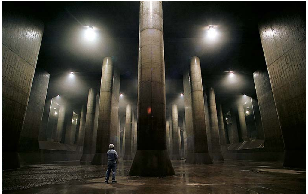
流入水の勢いを整える調圧水槽
