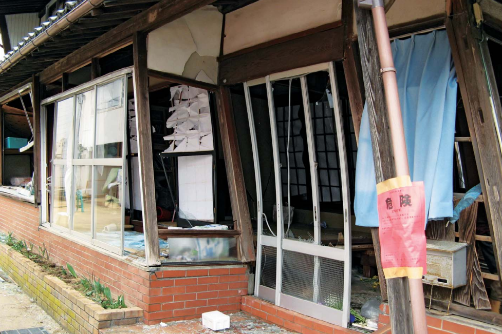
地震で被災した家屋
