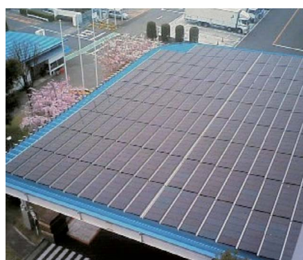
事業所の玄関屋根には太陽光発電装置を設置。災害時には、一時的な電力の供給が可能
