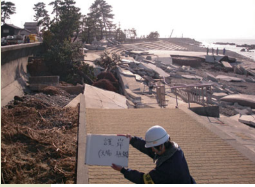
上：入善町芦崎海岸では、離岸堤や消波ブロックが数100mに渡って流され、砂地に散在した 下：護岸施設の復旧工事が終わり、整備された
