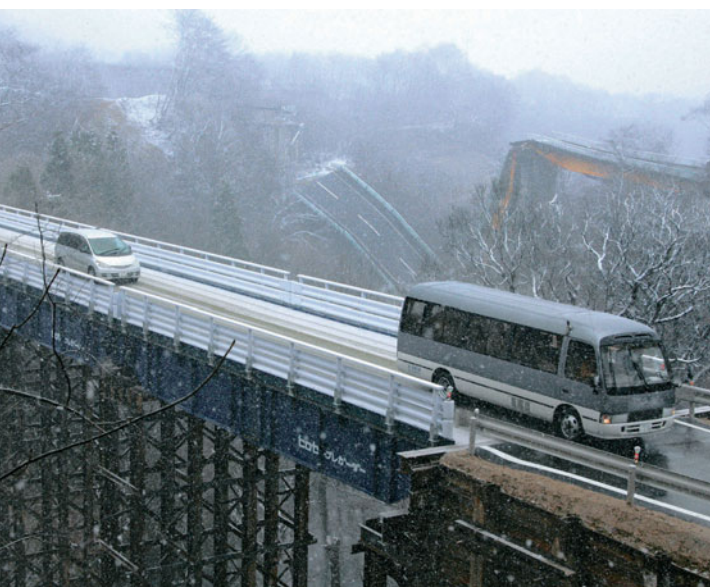
祭時大橋の仮設橋。後ろは落橋した橋 (写真提供: 共同通信社)
