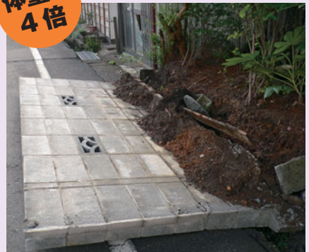
大きな揺れで倒れてしまうブロック塀もある。足が挟まれただけで、動けなくなることも
