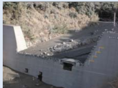
有村川第3砂防堰堤での観測
