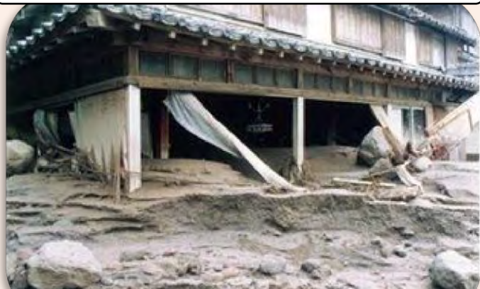
降灰後の降雨による土石流によって被害を受けた家屋
