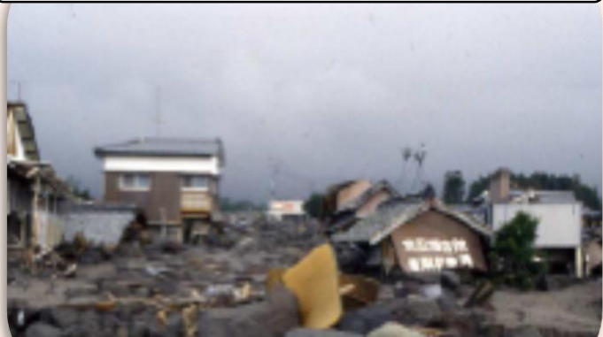
雲仙岳:土石流により被災した住宅(平成5年6月20日)
