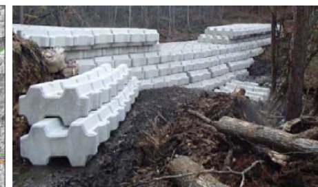
仮設堰堤の例(H26御嶽山)
