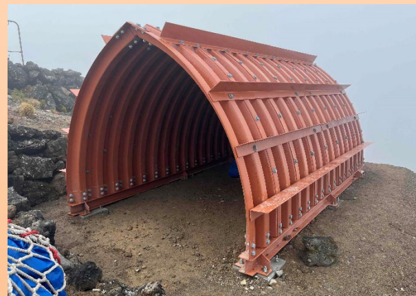
退避壕整備の例(岐阜県下呂市)
