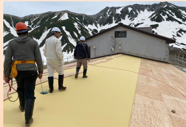
民間施設改修の例(富山県立山町)
