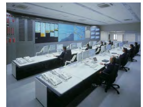
高機能消防指令センター
