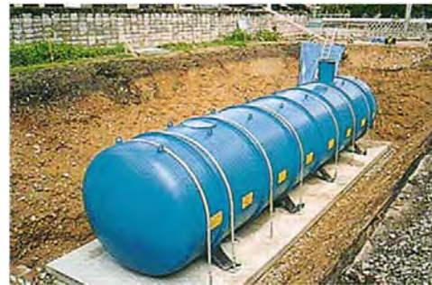
耐震性貯水槽
