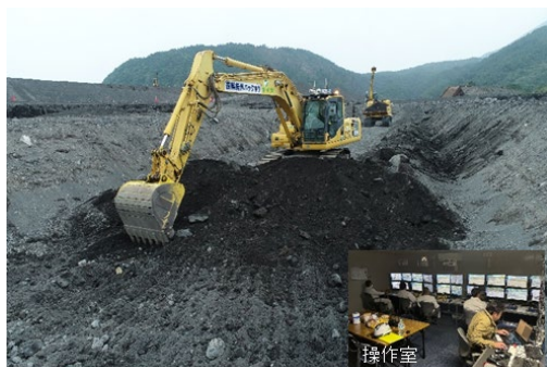
遠隔施工実証（桜島）
