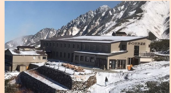
民間施設改修の例 (富山県立山町)
