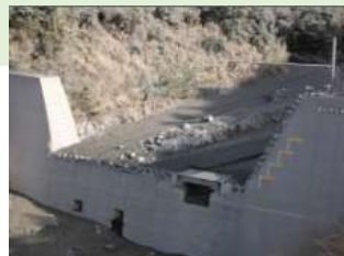
有村川における土石流観測
