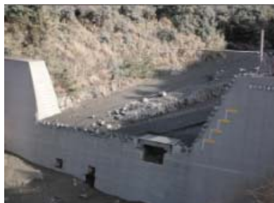
有村川第3砂防堰堤での観測
