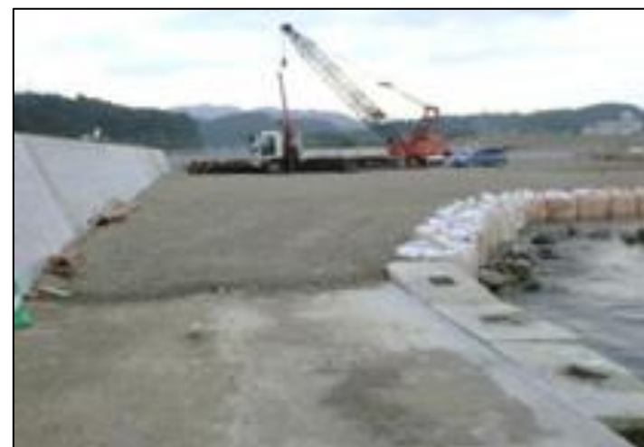
志津川漁港南防波堤復旧工事
