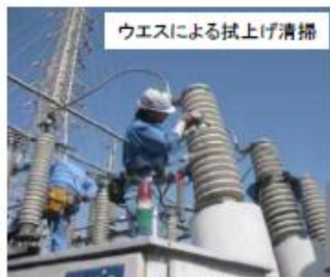
＜降灰除去作業の例＞
