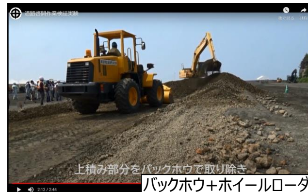
【出典】鹿児島市HP 大量軽石火山灰を想定した 車両走行・道路啓開作業検証実験
