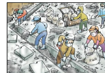
下水管や側溝の詰まりに留意
