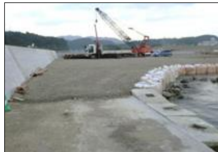
志津川漁港南防波堤復旧工事
