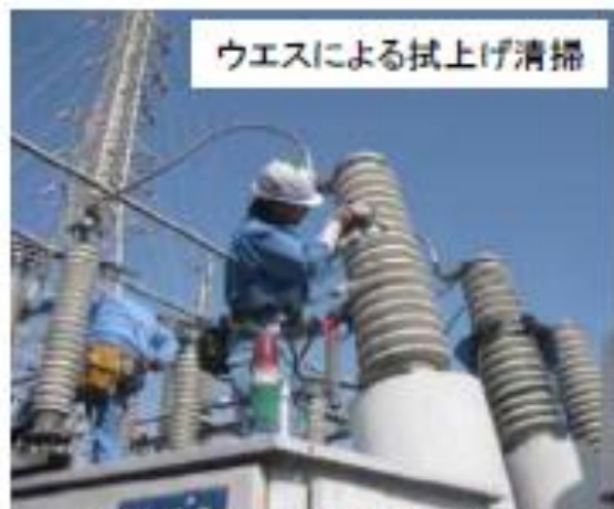
＜降灰除去作業の例＞
