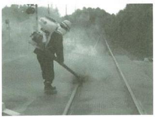
写真－6 灰の除去作業
