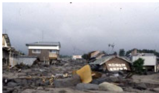
雲仙岳：降灰後の土石流により被災した住宅
