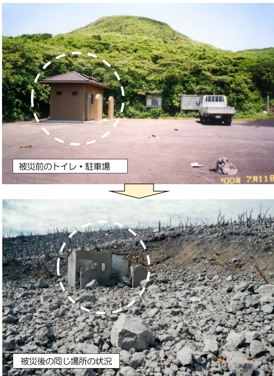
図 2-12 2000年三宅島噴火による噴石被害状況
