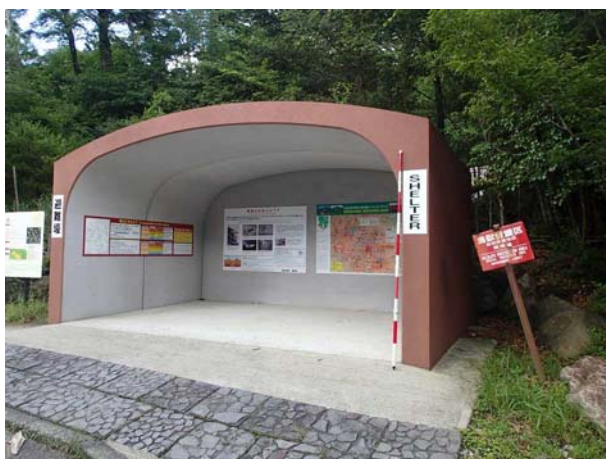
図 3-16 プレキャスト・コンクリート部材を組み立てる工法のアーチカルバート(霧島山)
