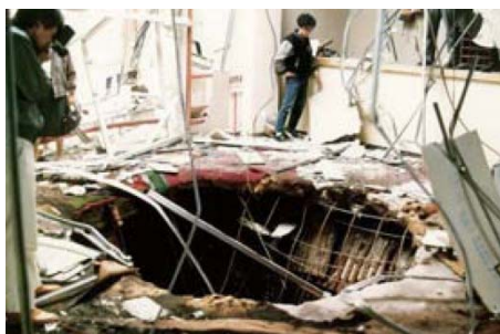
図 2-11 噴石被害の例 (火口から約3.2 km地点)
