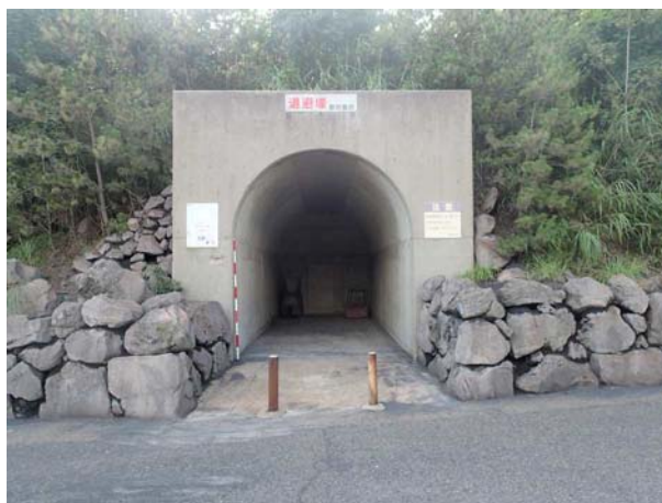
図 3-10 周辺が溶岩の岩塊で覆われているトンネル型退避壕（桜島）
