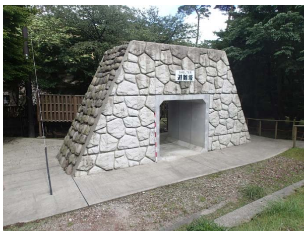
図 3-1 4 ボックスカルバートに敷砂緩衝材をした退避壕（霧島山）
