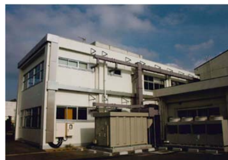
図 3-51 三宅小学校外観 （手前が脱硫装置）
