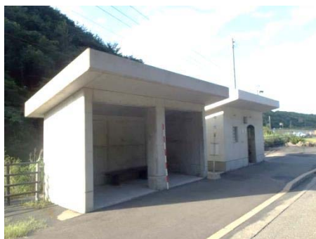
図 3-6 バス停として利用されている片屋根型退避壕（桜島）
