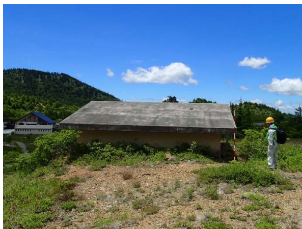
図 3-3 3 草津白根山の退避壕（屋根のコンクリート厚 20cm）
