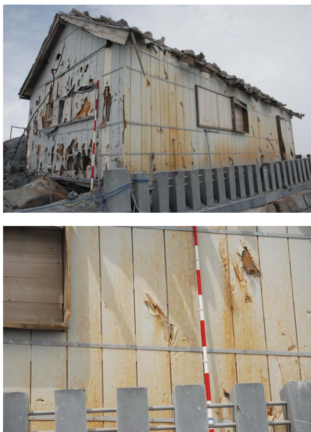
図 3-4 4 噴石による斜めの擦痕の例 （御嶽神社頂上奥社）
