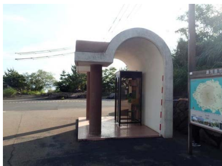
図 3-5 2 鉄筋コンクリートの覆いがある電話ボックス（桜島）
