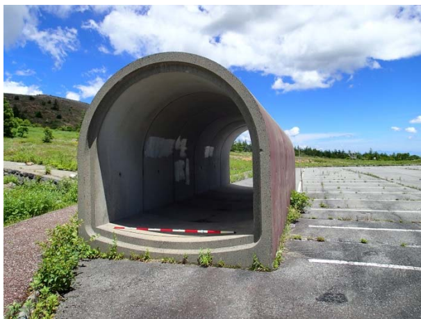
図 3-15 アーチカルバートを利用した退避壕(草津白根山)
