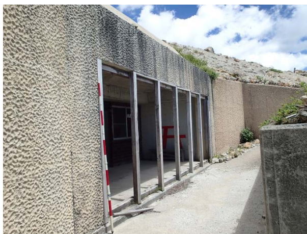
図 3-1 2 埋め戻し型退避壕の退避スペース（草津白根山）
