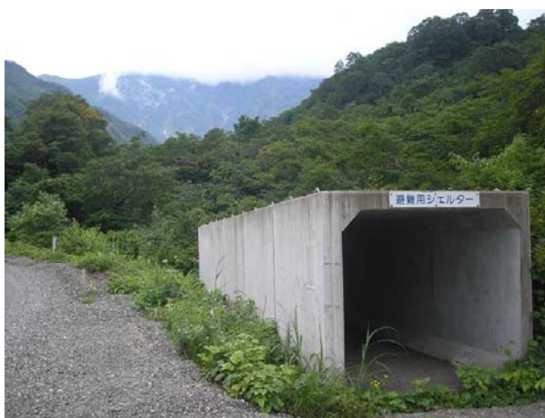
図 3-1 3 ボックスカルバートの退避壕（新潟焼山）
