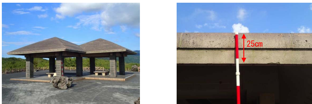
図 3-47 有村溶岩展望所のコンクリート製のあずま屋（桜島）
