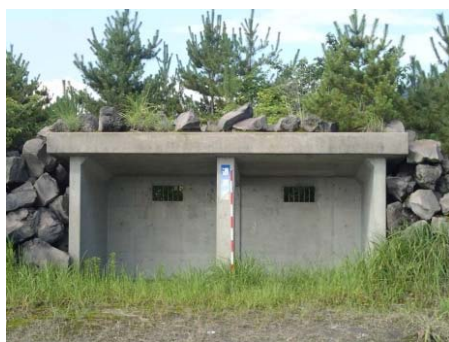
図 3-7 周辺に溶岩の岩塊がある片屋根型退避壕（桜島）
