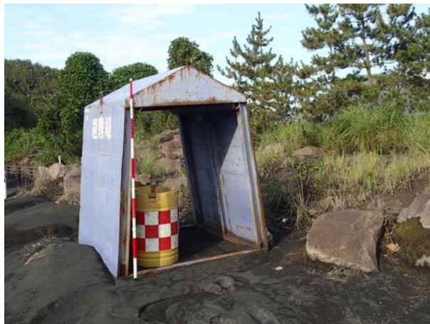
図 3-17 桜島の鋼製仮設退避壕
