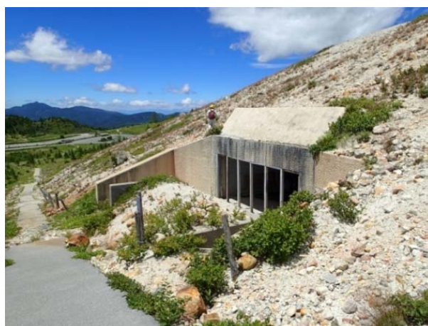
図 3-3 4 草津白根山の退避壕（天井部のコンクリート厚は 50cm 程度）
