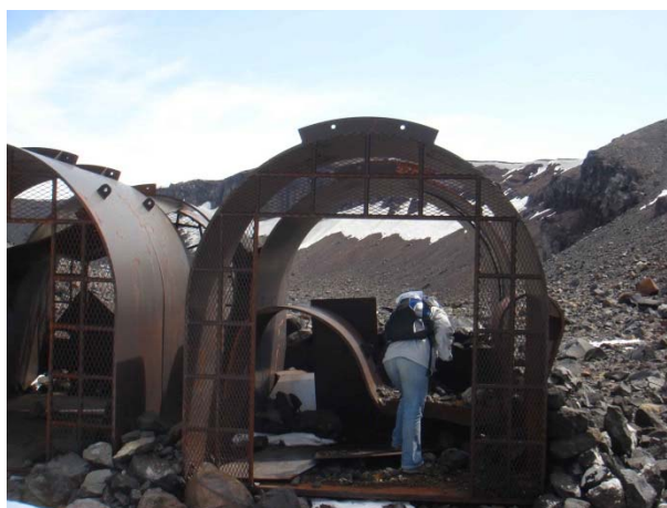
図 3-18 変形が認められる浅間山の鋼製退避壕
