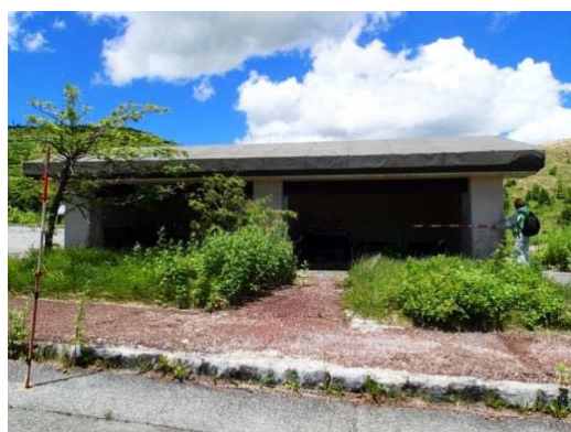
図 3-41 群馬県により設置された退避壕の例（草津白根山）
