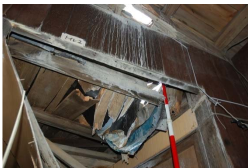
図2 噴石が山小屋の梁等に衝突し貫通を免れた例 (御嶽山・二ノ池本館)
